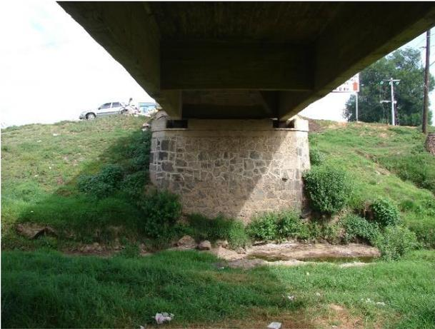
**Figura 5** Nervaduras del puente El Colorado
