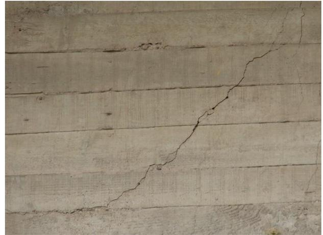
**Figura 7** Grieta inclinada en el extremo de la nervadura
