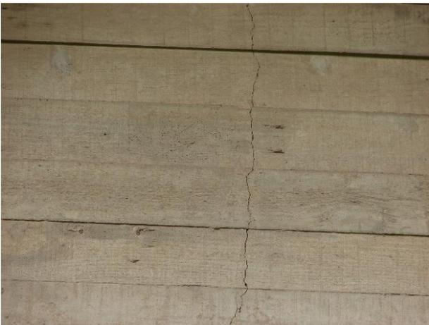
**Figura 6** Grieta vertical en la parte central de la nervadura
