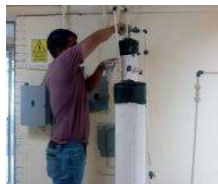
Figura 2 Purificador de biogás. Fuente: Elaboración Propia
