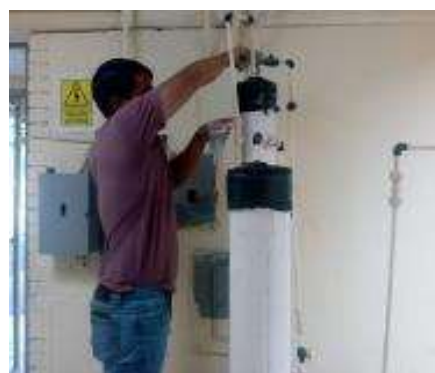
Figura 2 Purificador de biogás. Fuente: Elaboración Propia
