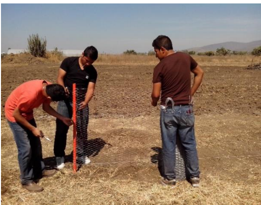
Figura 10 Colocación de soporte para cercado
