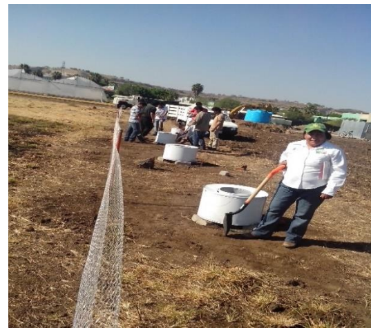
Figura 12 Colocación de dispositivos blanqueados
