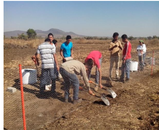
Figura 11 Colocación de malla
