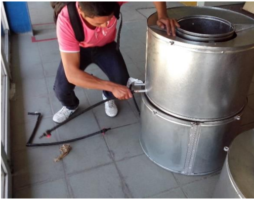
Figura 9 Colocación de líneas de dren
