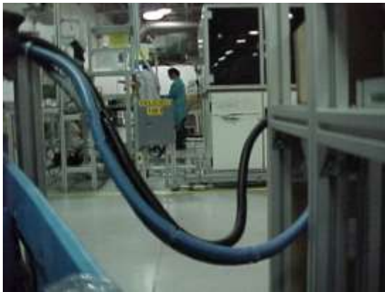
Figura 10 Instalación de estación de trabajo en área piloto
