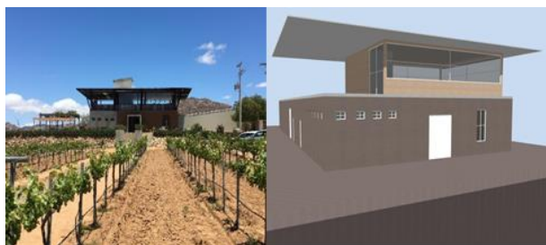
Figura 6 Izquierda: Cava de vino de referencia. Derecha: Cava de referencia en simulador Fuente: Elaboración propia
