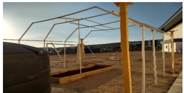
Figura 7 Estructura en PVC del domo con columnas metálicas de soporte
