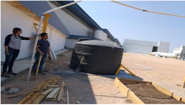
Figura 8 Primera cisterna de agua sobre la plancha construida
