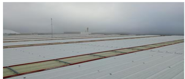
Figura 3 Superficie de techo de la UNAQ. Con canaletas hacia los desagües
