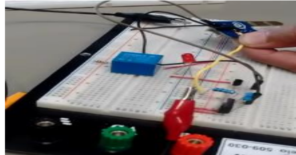
Figura 14 El regulador Im 7805 suministra energía a los sensores de humedad
