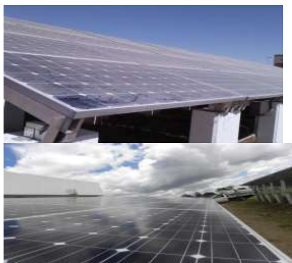
Figura 8 Paneles antes y después de aplicar la técnica de limpieza
