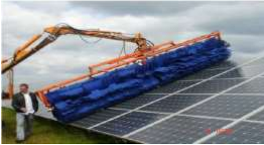
Figura 3 Técnica de rodillo autopropulsado
