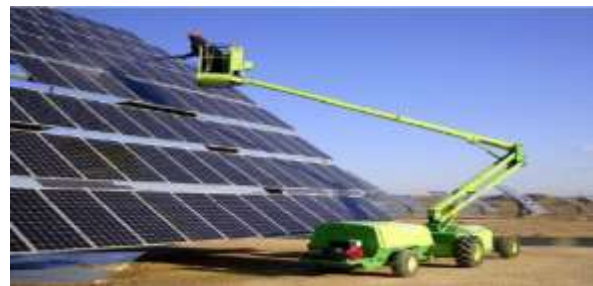
Figura 2 Técnica de Agua a presión
