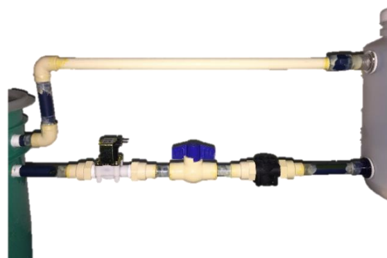
Figura 14 Conexiones entre contenedores
