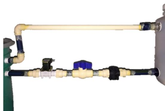
Figura 14 Conexiones entre contenedores
