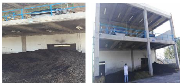
Figura 1 Depósito de lodo residual de SITRATA
