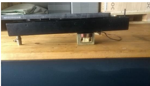
Figura 6 Transformador ensamblado en la canaleta inferior
