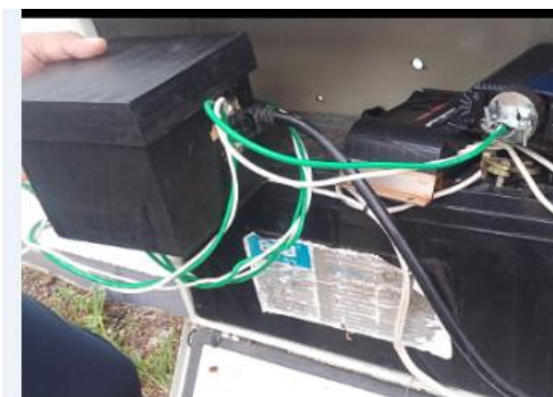
Figura 2 Conexión de Bateria y modulo WI-FI
