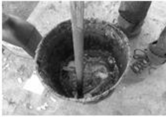
Figura 1 preparación del impermeabilizante
