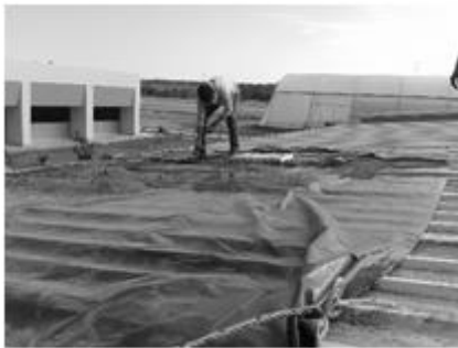
Figura 2 Colocación de hule anti raíz.
