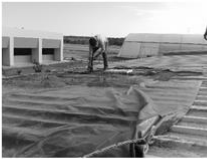
Figura 2 Colocación de hule anti raíz.
