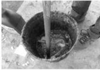
Figura 1 preparación del impermeabilizante
