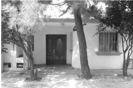
Figura 5 Fachada principal de la primera vivienda. Fotografía de la autora.
