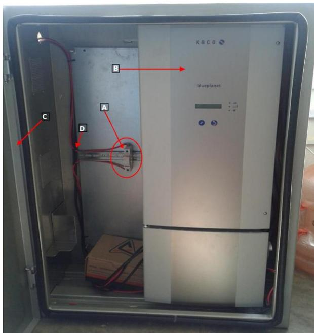
**Figura 1** Inversor montado dentro del gabinete.
