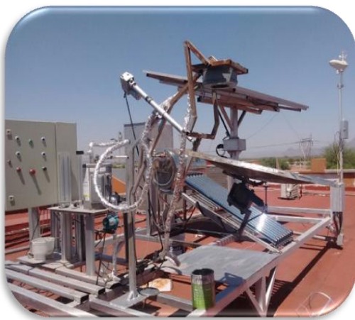
Figura 11 Plataforma solar ITESCA.
