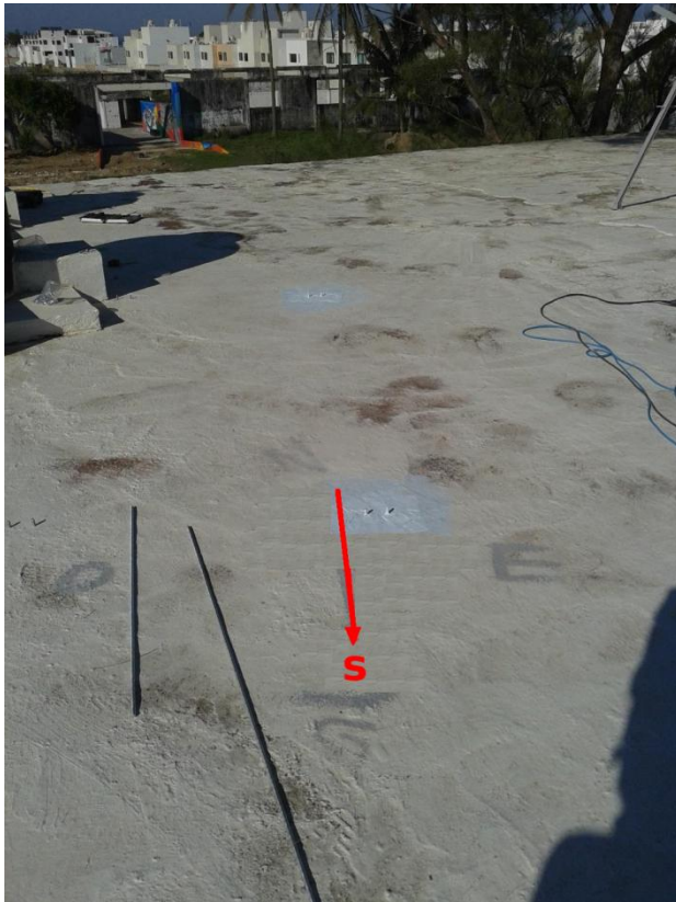
Figura 3 Ubicación física de los paneles FV.
