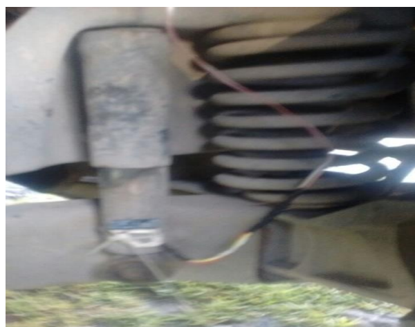
Figura 14 Acoplamiento del sensor al sistema de suspensión
