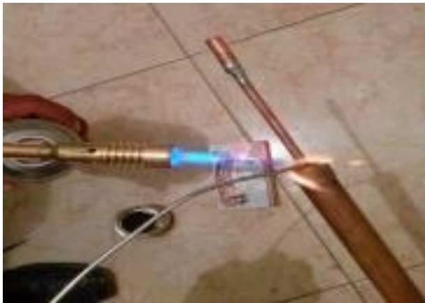
Figura 1 Pre ensamble de tubos
