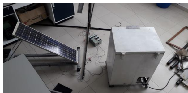
Figura 4 Refrigerador y panel solar conectados
