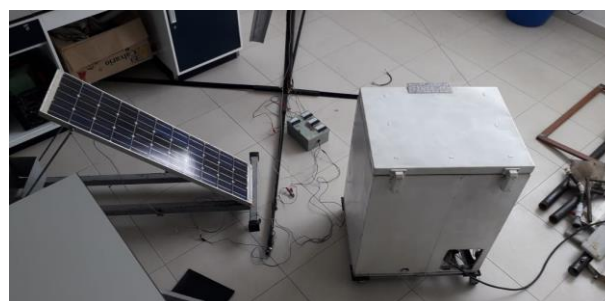
Figura 4 Refrigerador y panel solar conectados
