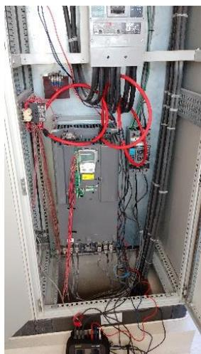
**Figura 3** Analizador de redes instalado
