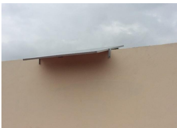
Figura 5 Paneles solares monocristalino y policristalino montados a veinte grados.
