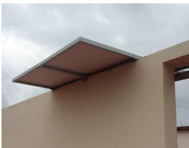
Figura 4 Paneles monocristalino y policristalinos montados a cero grados.
