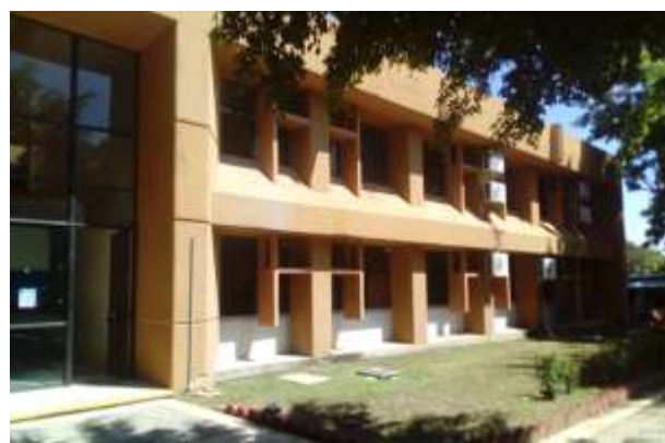
Figura 8 Edificio de los 700's del Instituto Tecnológico de Acapulco, perteneciente a la carrera de Ingeniería de Sistemas Computacionales
