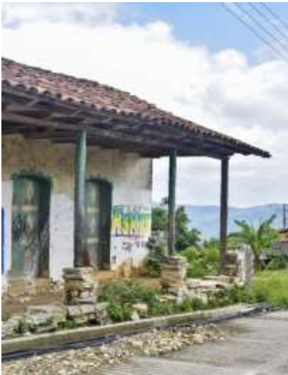
Figura 5 Vivienda vernácula con puertas de arco rebajado; pórtico con columnas de madera y techo con vigas de madera y teja de media caña.
