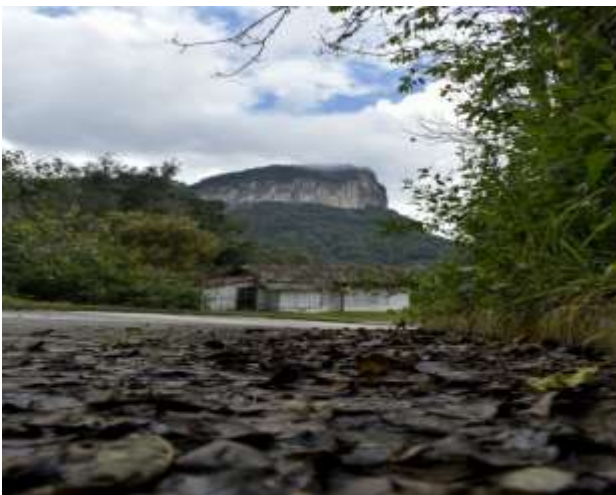
Figura 4 Vivienda vernácula rural al pie de la carretera muros entablados de madera, cubierta con vigas de madera y teja de media caña Fuente: Hernández (2018).
