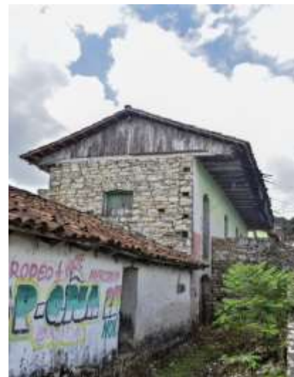
Figura 4 Vivienda vernácula de dos niveles con ventanas y puertas de marco de piedra de arco rebajado. Techo de vigas de madera y entablado de madera con tejas de media caña.
