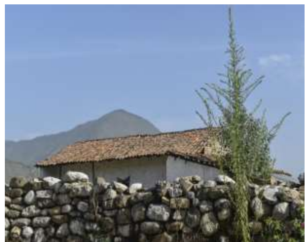
Figura 6 Vivienda vernácula con cubierta de vigas y morillos de madera con teja de barro de media caña Fuente: Hernández (2018)
