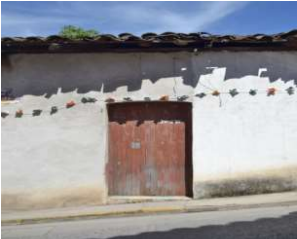
Figura 3 Vivienda vernácula hacia la calle, sin ventanas, arco tendido en el marco de la puerta, muro de adobe cubierto con mortero para protegerlo de la lluvia intensa y cubierta con vigas de madera y teja de barro teja de media caña.
