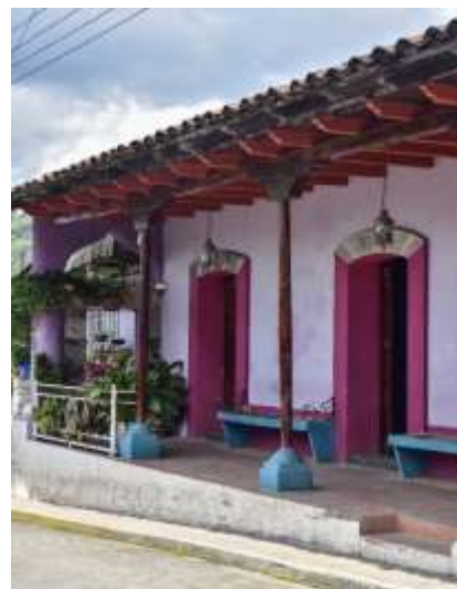
Figura 3 Vivienda vernácula hacia la calle con pórtico de columnas de madera y soportes de ladrillo y piedra. Marcos de piedra en puertas de arco rebajado. Bancas adosadas al muro como punto de reunión Fuente: HERNÁNDEZ (2018)
