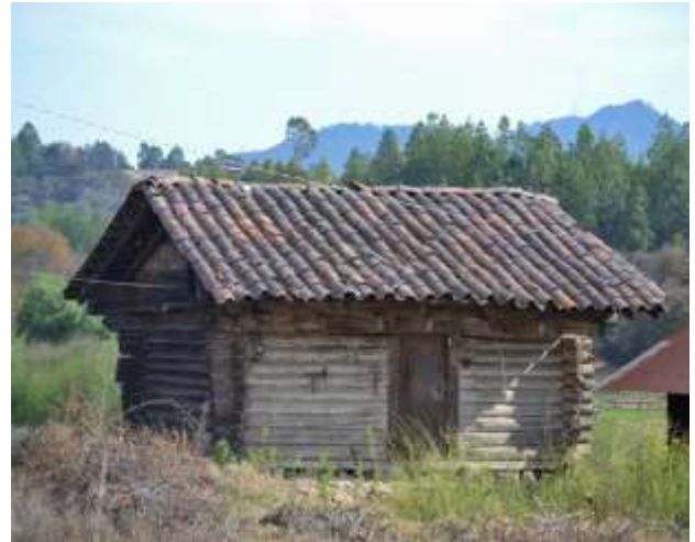
Figura 5 Vivienda vernácula rural de madera con morillos, sin ventanas, marcos de madera en puerta con techo de vigas de madera y teja de media caña Fuente: Hernández (2018)
