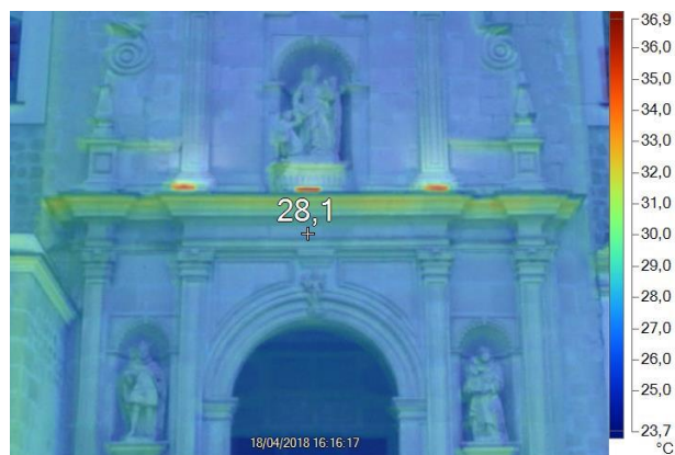
Figura 5 Imagen térmica del exterior del muro evaluado Fuente: Los autores
