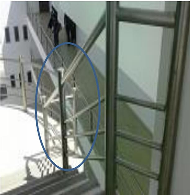
**Figura 12** Barandales de escalera con presencia de suciedad y en estado de oxidación
