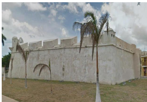
Figura 4 Muro C - D, con dos de las tres garitas y una cortina que une al baluarte de San Juan. Fuente: Propia (2017). Vista del Baluarte Santa Rosa desde el Sur [fotografía]
