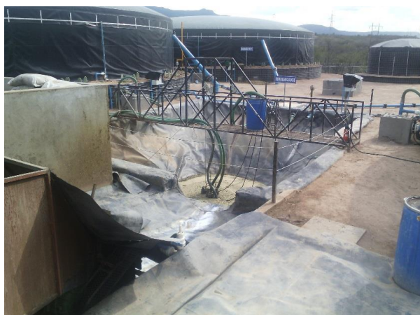
Figura 13 Pileta de Biomasa
