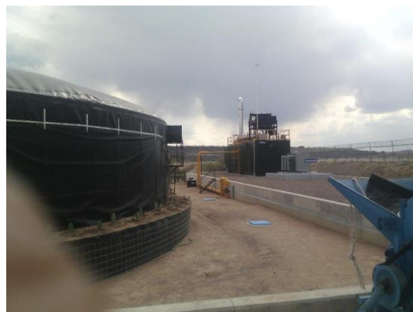
Figura 16 Generador Eléctrico mediante Biogás
