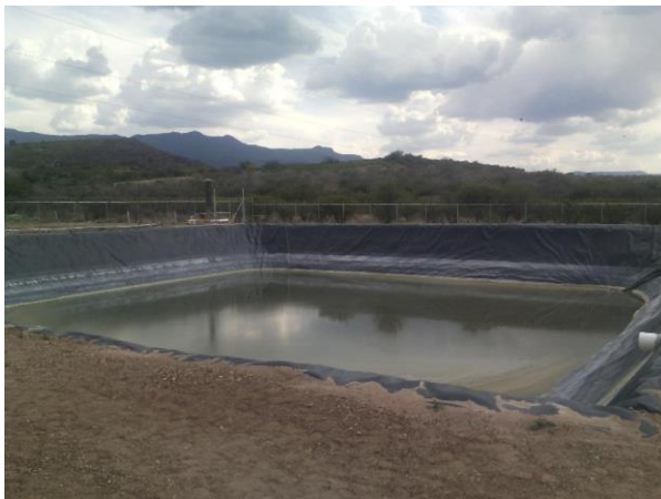
Figura 17 Fosa de recepción de Sobrantes de la Biomasa.
