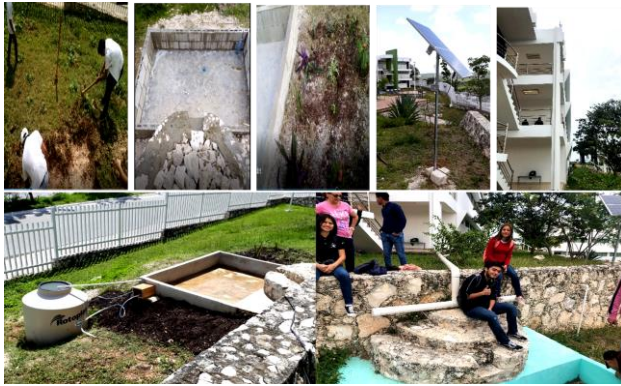
Figura 8 Construcción e implementación del sistema de captación de agua en sus diferentes etapas.
