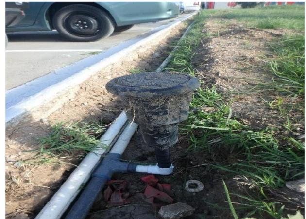
**Figura 4.** Rociadores del sistema de riego
