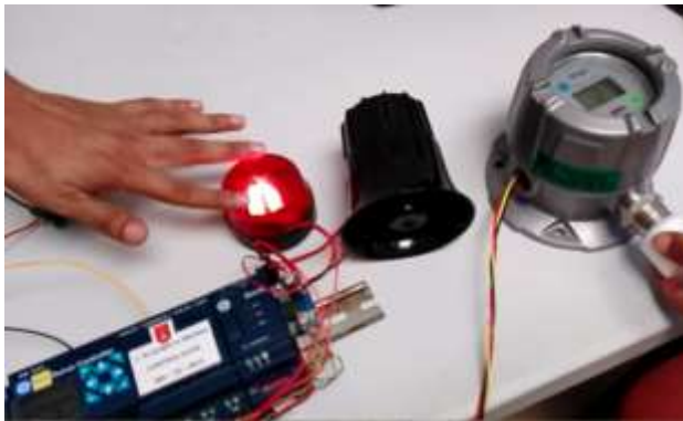
Figura 7 Prueba en laboratorio del sensor, el programa del PLC y alarmas
