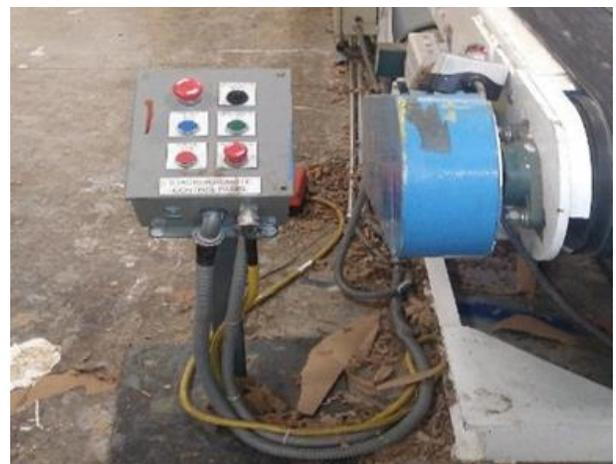
Figura 5 Instalación de Interruptor de botón momentáneo
