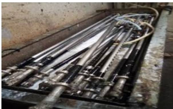
Figura 5 Área de manifolds Fuente: Empresa (caso de estudio)
