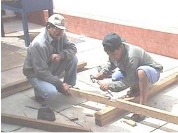
Figura 2 Preparación de Armazón de madera (tipo caballete)
