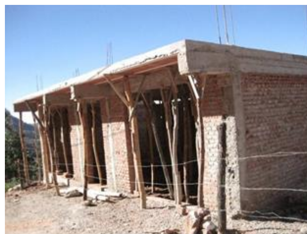
Figura 13 Vivienda en la Zona de Lechuguillas
