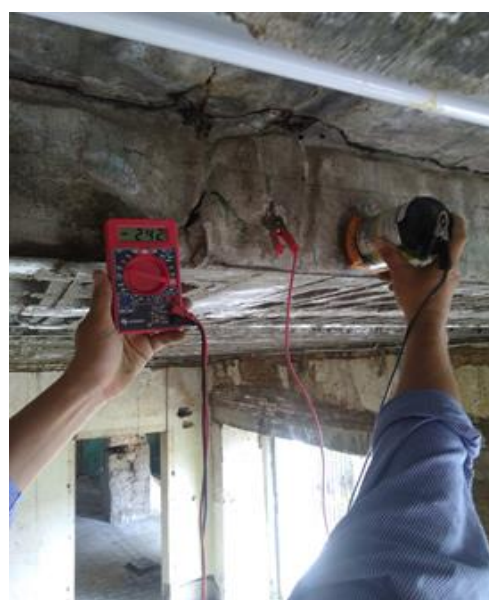
Figura 9 Arreglo de media celda para pruebas de potenciales de corrosión ( E_{corr} )
