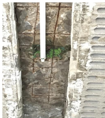
Figura 3 Lixiviación de los productos solubles (Vista del lecho inferior de la techumbre)
