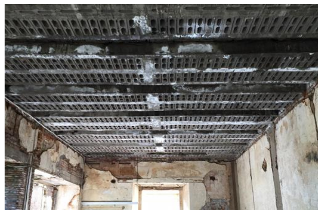
Figura 2 Vista general de la techumbre (Zona 1).
