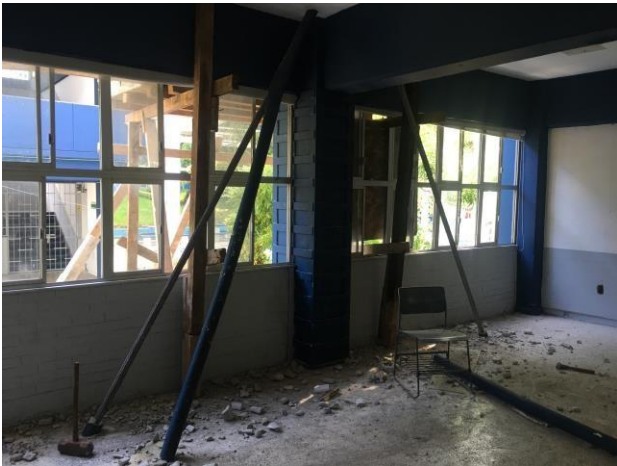
Figura 3 Interior del edificio
