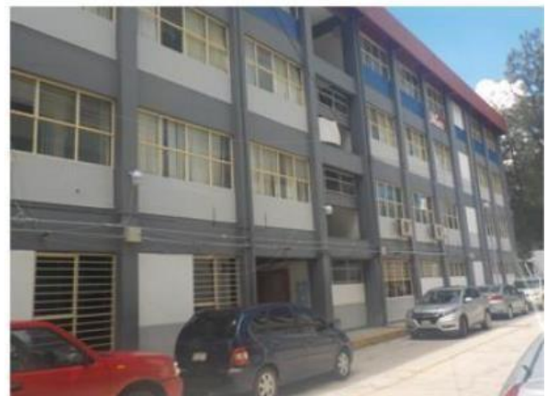
Figura 1 Vista lateral del edificio
