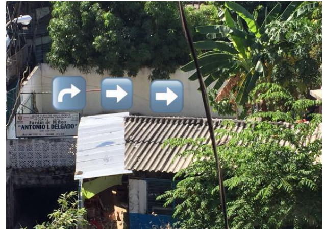
Figura 8 Jardín de niños Antonio I. Delgado. (clausurado por daños estructurales)
