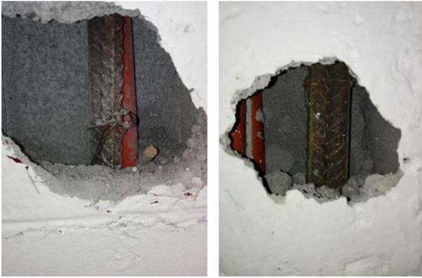
**Figura 9** Deficiencias en la colocación y llenado de celda con acero de refuerzo vertical
