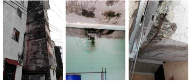
**Figura 8** Humedad y corrosión del acero de refuerzo en los edificios analizados
