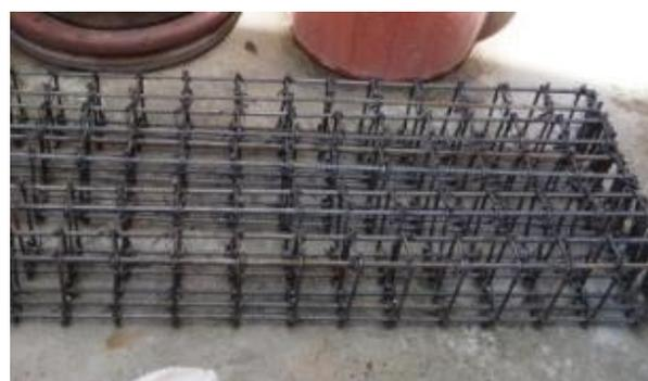
**Figura 2** Acero de refuerzo en vigas
