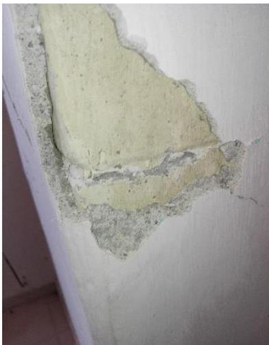
**Figura 10** Celda rellena correctamente
