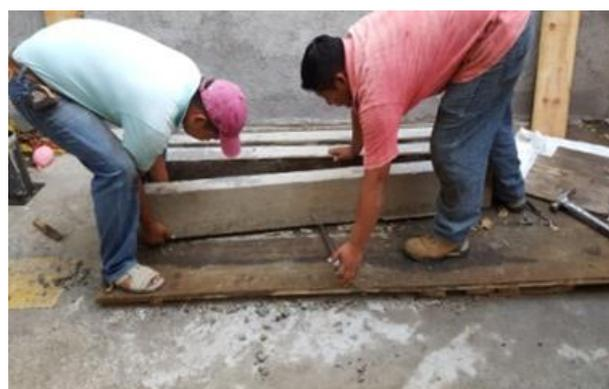
**Figura 7** Descimbrado de vigas
