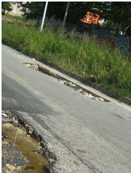
Fotografía 10 Daños en la Carreteras Asfáltica Campeche, Campeche, Ciudad Concordia, Calle 4 Este, 8, 24085, México
