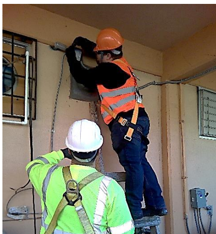
Figura 3 Instalación de canalizaciones Fuente: Elaboración Propia
