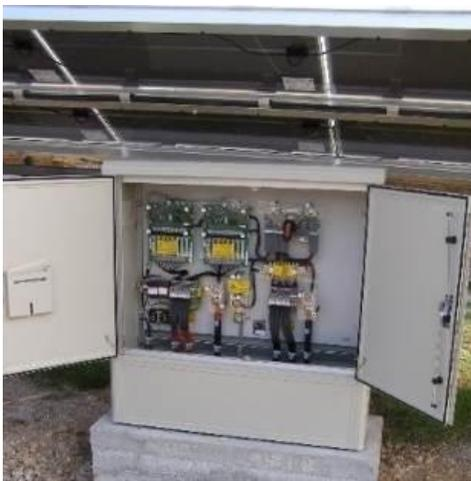
**Figura 1.3** Caja de conexión real de un sistema fotovoltaico (Yaru Mendez)
