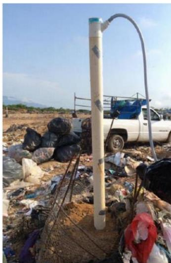
**Figura 1** Salida de Biogás en relleno sanitario.
