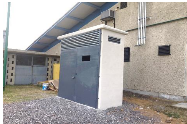
Figura 16 Fase de desarrollo de la caseta en donde se ubican los inversores y el sistema de monitoreo y control eléctrico
