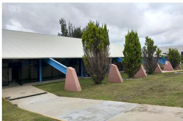
Figura 14 Vista del edificio ‘k’ en la Universidad Tecnológica De San Juan Del Río antes de implementar el sistema fotovoltaico
