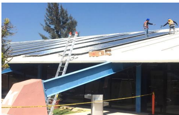
Figura 16 Instalación de los paneles solares con sus respectivos soportes de fijación
