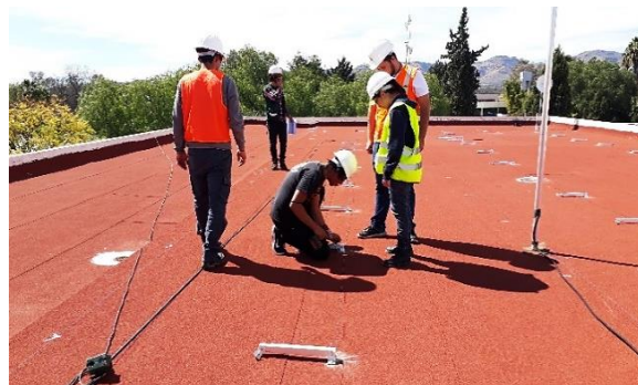
Figura 1 Trazo para colocación de rieles de estructura metálica
