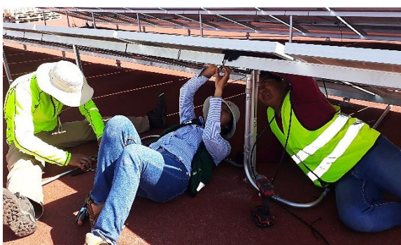
Figura 5 Conexión de módulos Fuente: Elaboración propia
