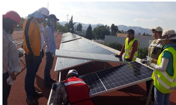
Figura 3 Instalación de módulos Fuente: Elaboración propia
