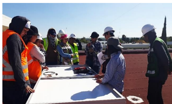
Figura 2 Medición de parámetros eléctricos en módulos
