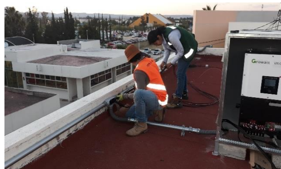
Figura 6 Instalación de cable e inversores Fuente: Elaboración propia
