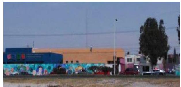
Figura 1 Fachada del Centro de Rehabilitación
