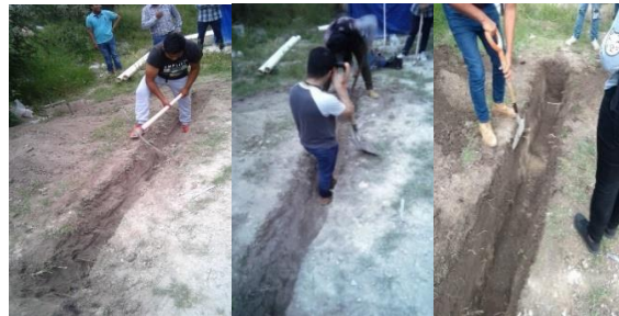
Figura 1 Excavación de la zanja donde se va a instalar el biodigestor
